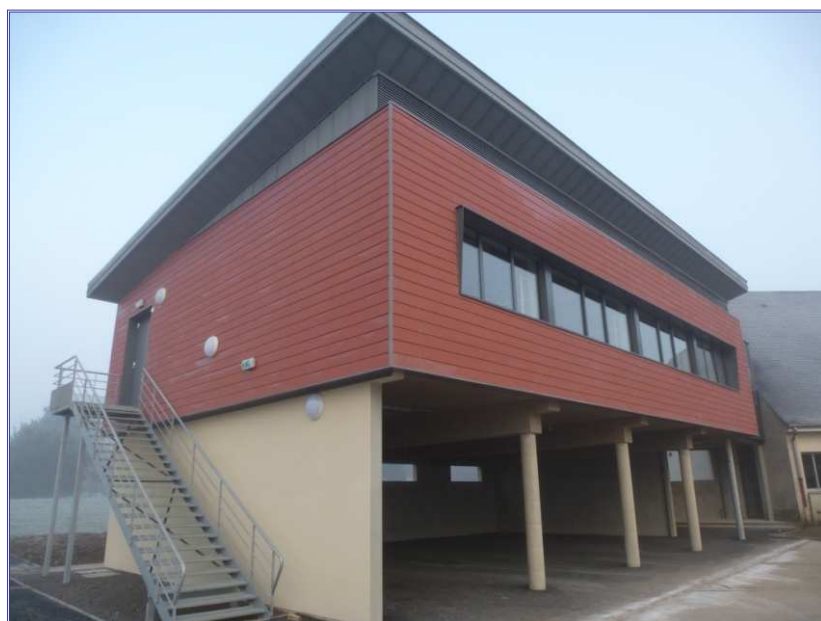
Construction d'un préau et du CDI
