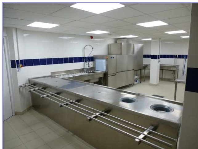
Création d'une laverie
