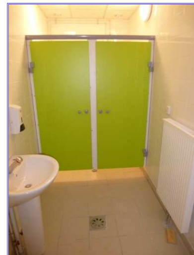
Aménagement des sanitaires
